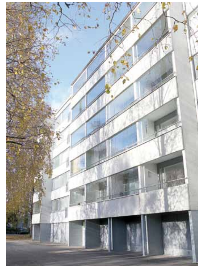
As Oy Toukolanpuiston julkisivuremontissa uusittiin mm. ikkunat tuloilmaikkunoiksi. Myös ovet uusittiin ja talon sokkeli maalattiin omin voimin. Nyt talossa kelpaa taas asua.
