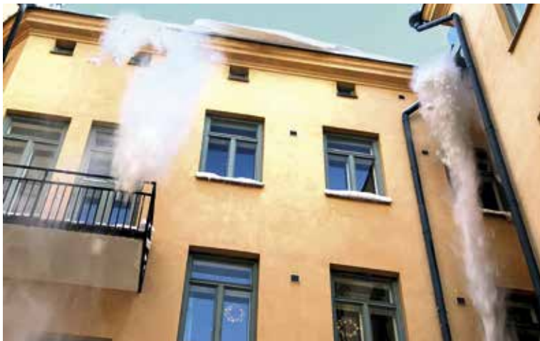
Taloyhtiö vastaa kiinteistön alueen turvallisuudesta, vaikka lumenpudotuksen hoitaa huoltoyhtiö. Kuva: KattoHoiva
