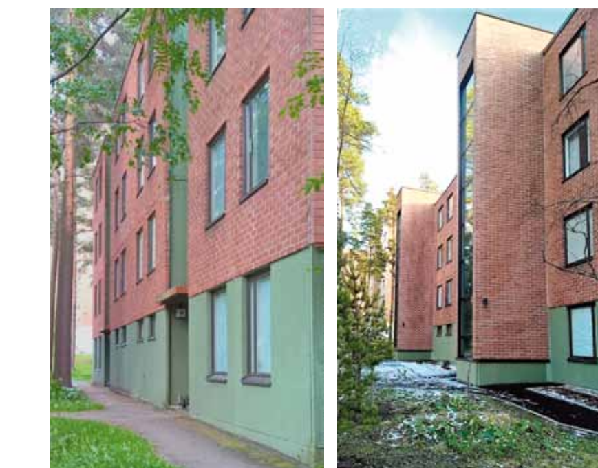
JULKISIVU ENNEN JA JÄLKEEN – HISSIKUILUT SULAUTUVAT TIILISEINUSTAAN.
