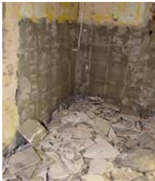
Riihikulman kylpyhuoneet purettiin paljaaksi rakenteisiin asti. Linjasaneerauksen yhteydessä uusitaan myös sähkölinjoja.
